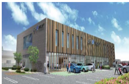
ZEB認証店舗の新築
